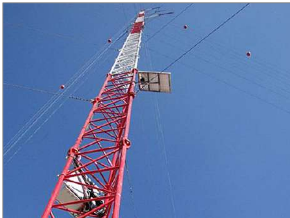
Torre de medición de velocidad y dirección de viento y variables ambientales para evaluación del potencial de generación eólico.
